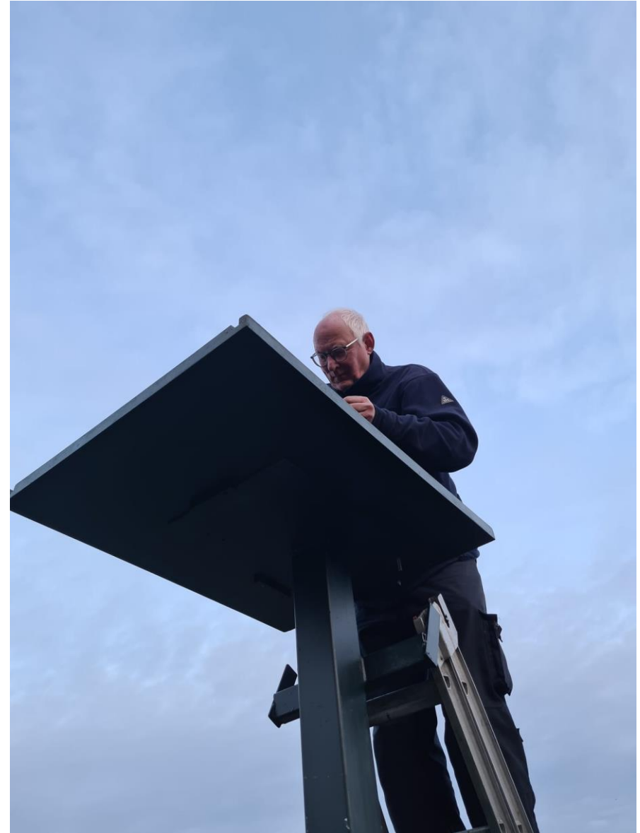
Het plaatsen van het platform
