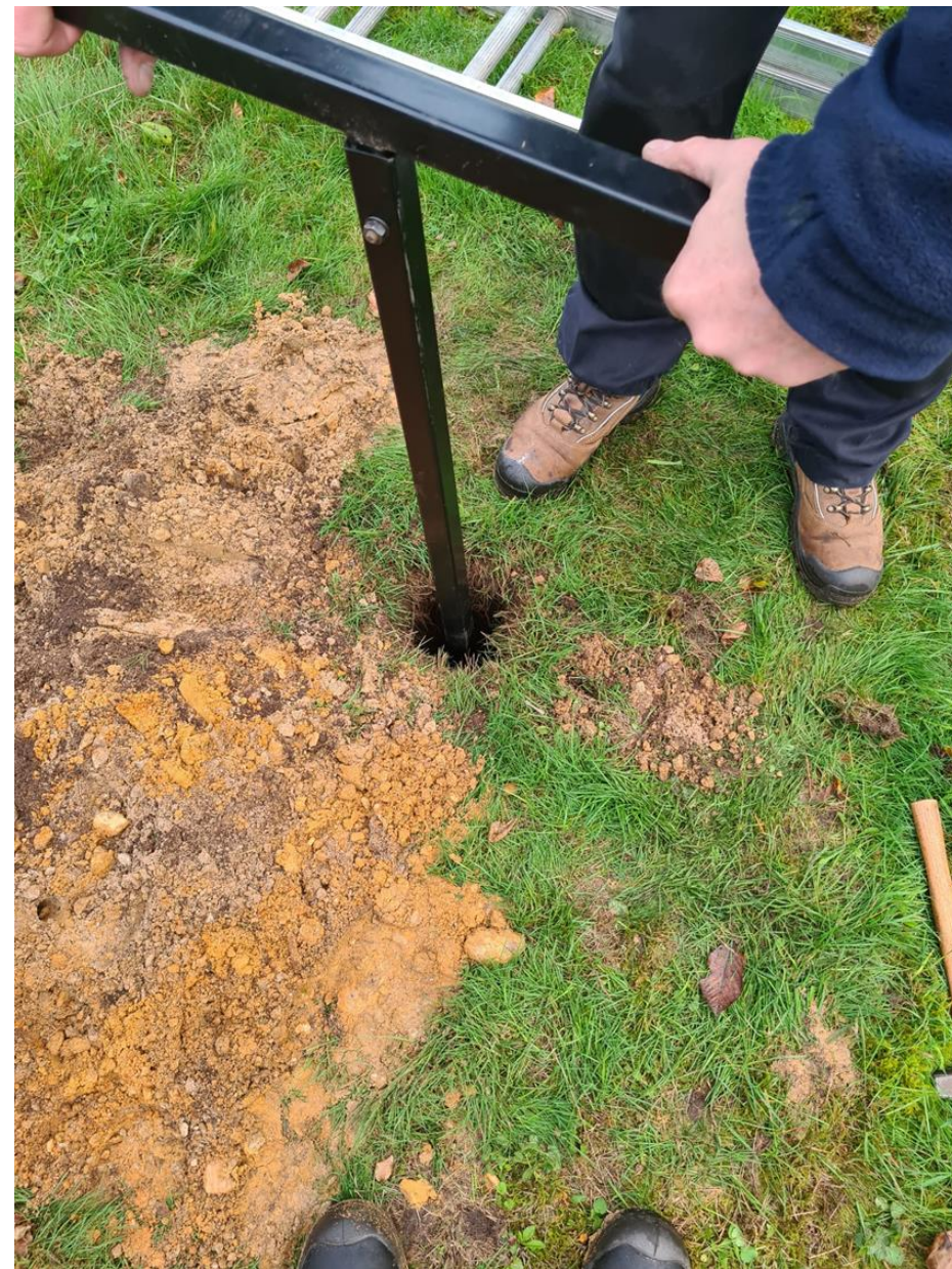
Het boren in droge grond
