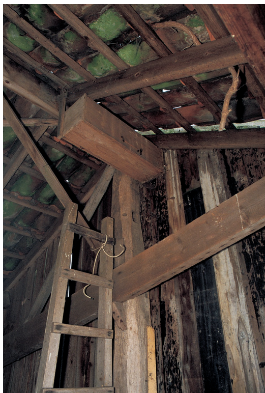
Nestkast in de nok van een schuur.
