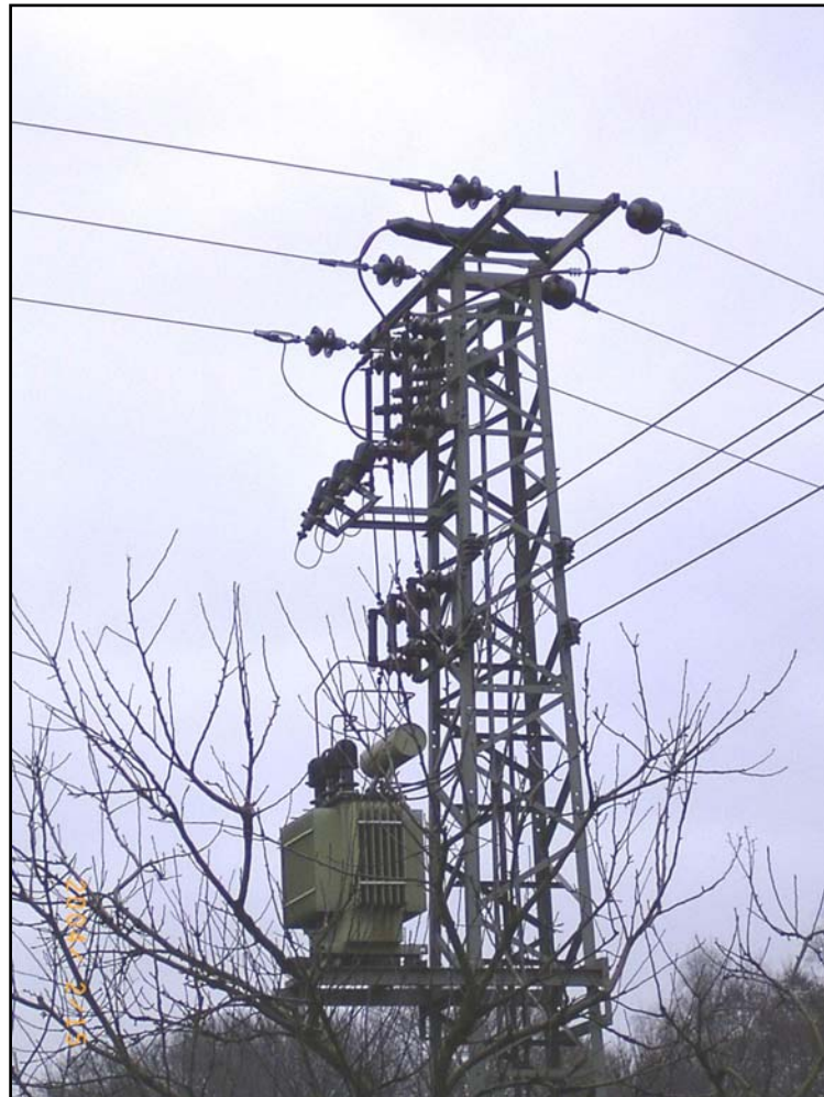
Foto 1. (Gejo Wassink, 2004). Beschermende maatregelen bij een elektriciteitsmast in het Teutoburgerwald (Ibbenburren). Bovenop is een plastic kapje geplaatst, zodat de uilen niet op de metalen delen landen. Om verbindingsdraden zijn plastic slangen aangebracht.
